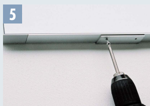
5 付属のLアングルで壁面へ取り付けます。
