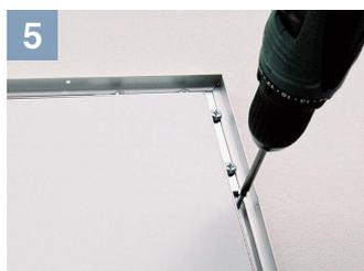
5 フレームの溝から壁面へ取り付けます。
